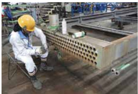
リチュービング工事
