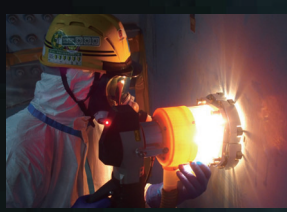
JPL工法®による塗膜除去
