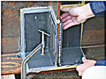
Step3 CFRP板接着・固定
