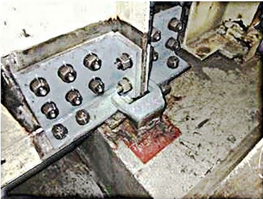
鋼板あて板による補強例
