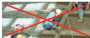
モルタル吹付
