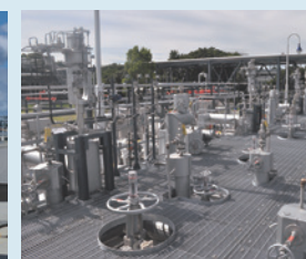
床板グレーチング
