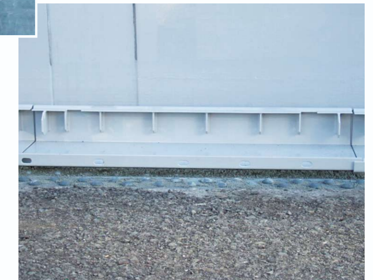
B・D 連結路 流水プレート設置後
