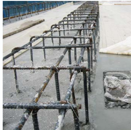
床版コンクリート打設後
