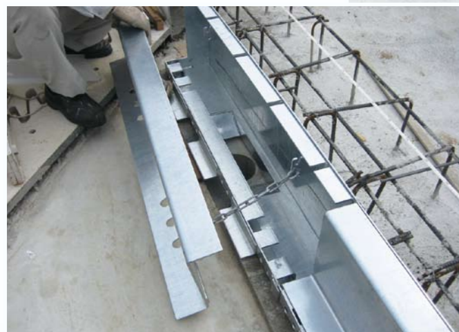
鋼製排水溝設置後
