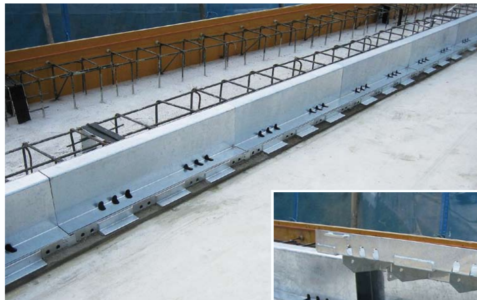
鋼製排水溝設置後
