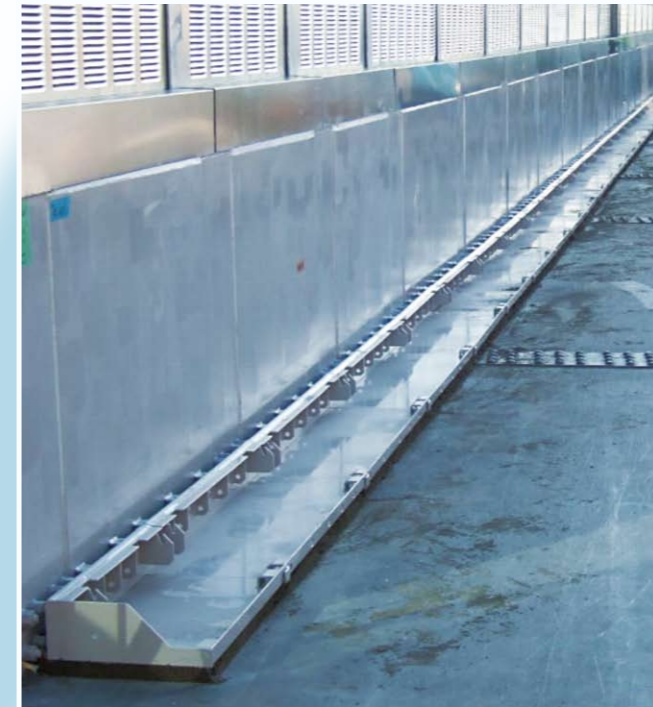
B・D 連結路 流水プレート設置後
