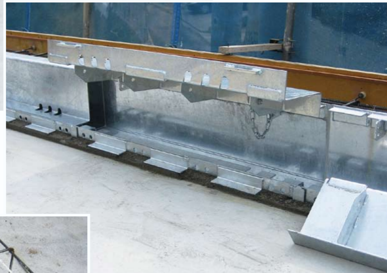
鋼製排水溝設置後
