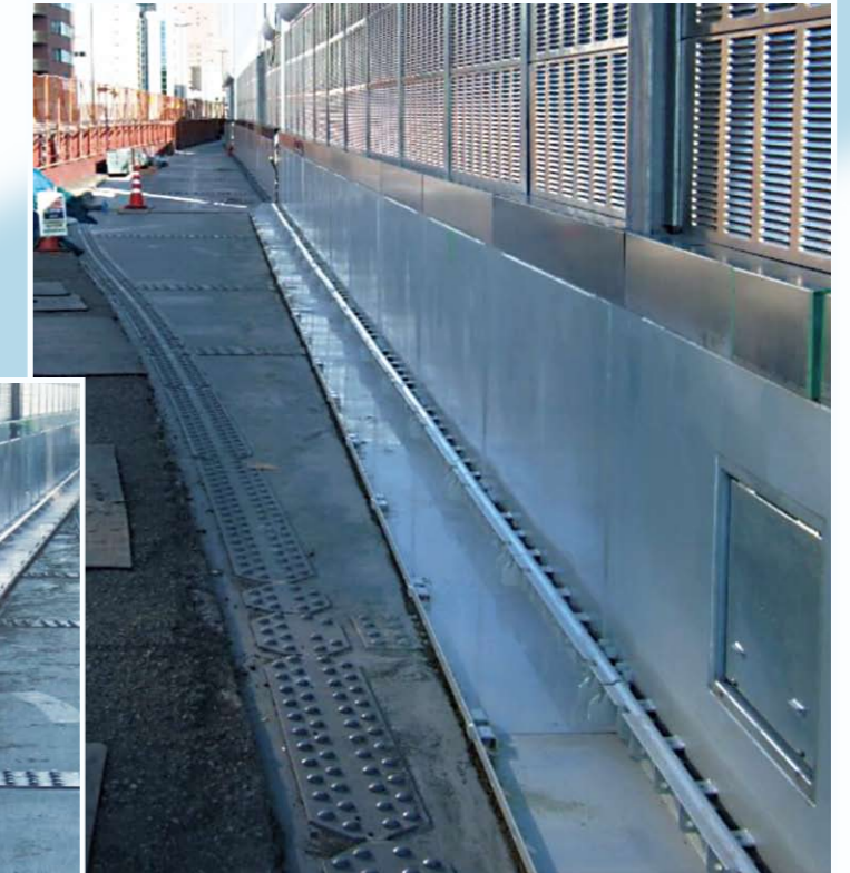
B・D 連結路 流水プレート設置後
