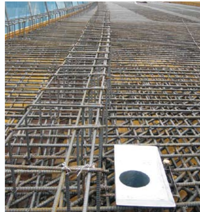
流末管設置後
